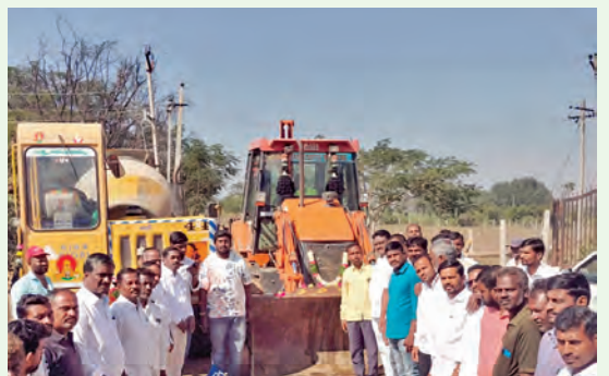
నూతన బిటీ రోడ్డు పనులను ప్రారంభిస్తున్న నాయకులు
